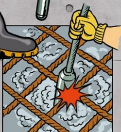
Zabraň kontaktu vibrátoru s vztuží a bedněním.
