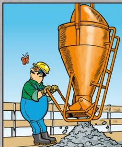
Ukládáním betonu přesně na požadované místo se vyhněš nutnosti dále s ním hýbat.
