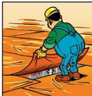
Nebo udržuj povrch betonu mokry a zakryj ho fólií nebo rohožemi.
