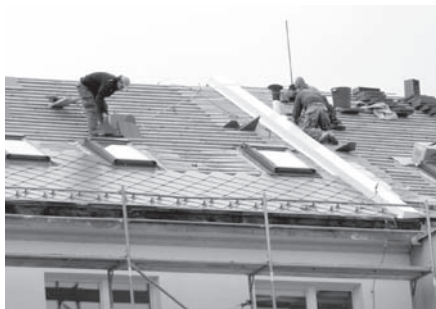
Rekonstrukce střech na budovách školy, červenec 2008 (spš)
