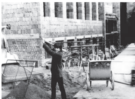
Na stavbě se podíleli v rámci praxe i studenti školy, 1982/83 (mk)
