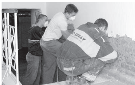
Studenti 2. ročníku odstraňují v rámci praxe povodní zasažené omítky suterénu, 9. 9. 2002 (spš)
