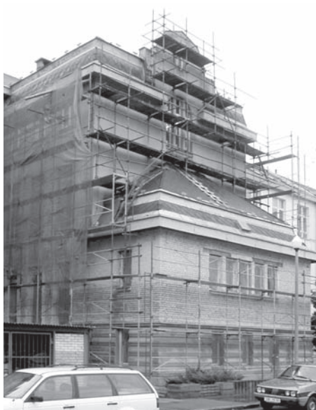
Rekonstrukce jižního průčelí budovy školy, březen 2002 (spš)
