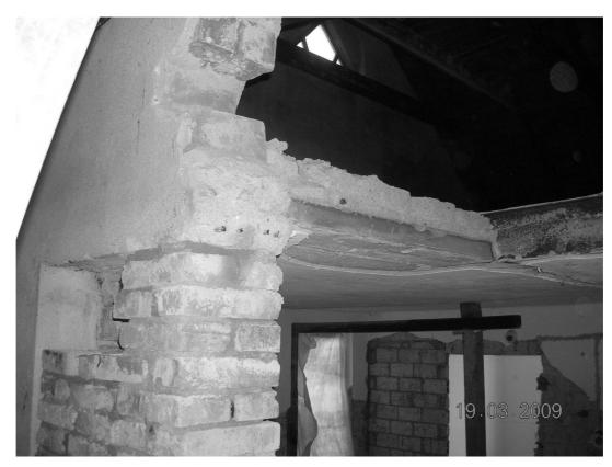
Obrázek 2 – fotodokumentace z 03/2009 – skladba stropu nad 1.NP
